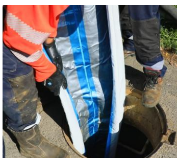
Gainage du collecteur amont de la station des Arthauds
