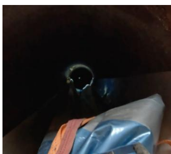
Gainage du collecteur amont de la station des Arthauds
