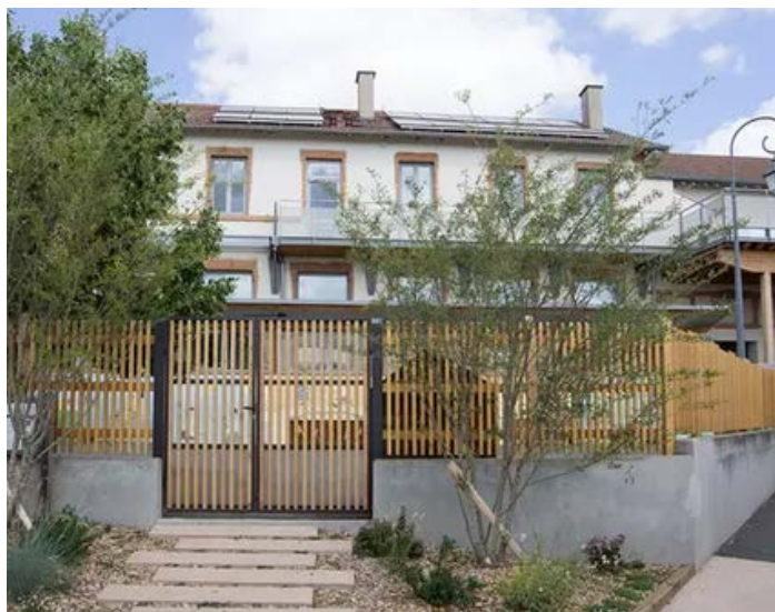
Chauffage en géothermie pour la mairie, la salle des Fêtes et les écoles de Les Olmes
