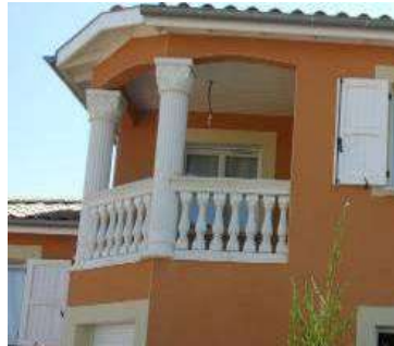
Type de balustres interdites
