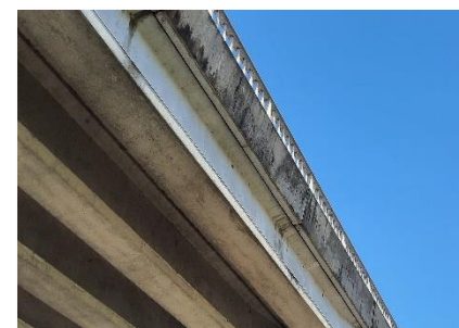
Pont de la N7 potentiellement favorable au gîte des chiroptères- Symbios
